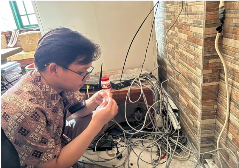
Gambar 10. Proses Penataan Kabel dan Konfigurasi Perangkat Jaringan
