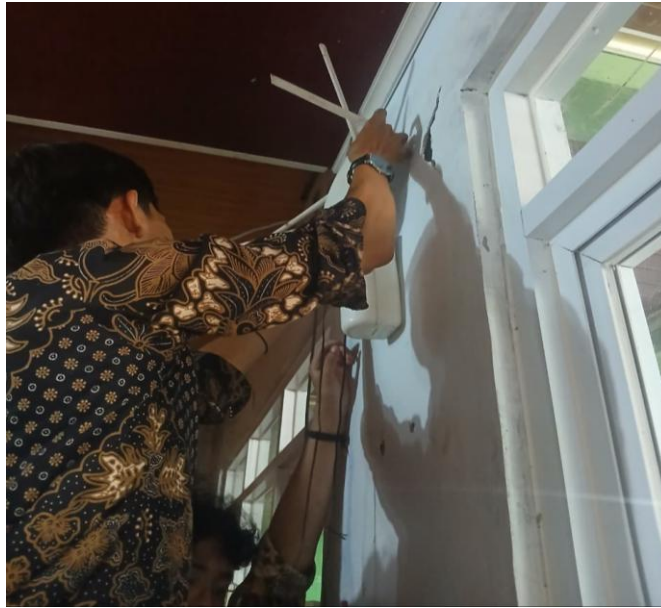
Gambar 8. Proses Pemasangan Switch dan Konfigurasi Access Point di Ruang Multimedia.
