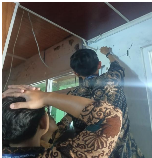
Gambar 9. Proses Pemasangan Switch dan Konfigurasi Access Point di Ruang Multimedia
