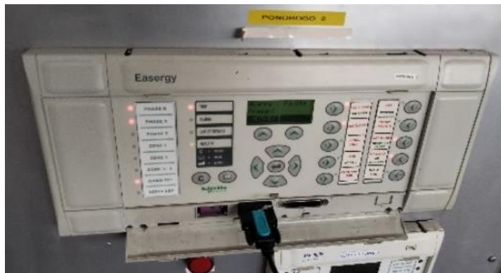
Gambar 12. Relay Distance Gardu Induk Dolopo.
