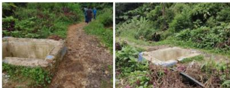
Gambar 5. Kondisi Awal Bak Penenang.
