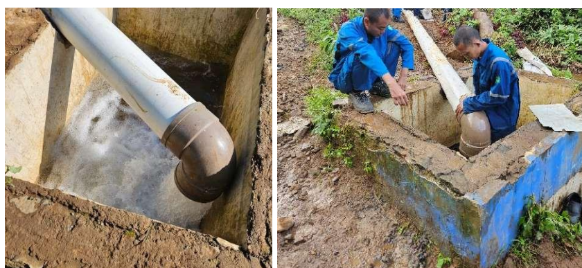
Gambar 3.4.4.2 Struktur Bak Penenang
