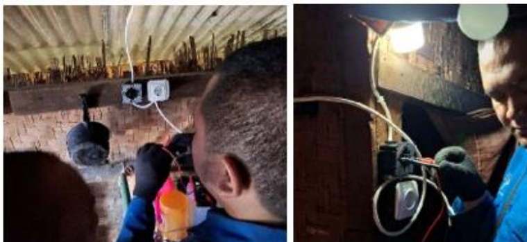
Gambar 16. Pemasangan dan Pengujian Rangkaian Listrik.
