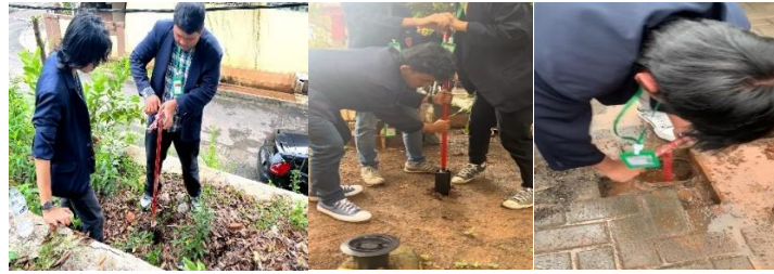
Gambar 18. Praktek Lubang Resapan Biopori
