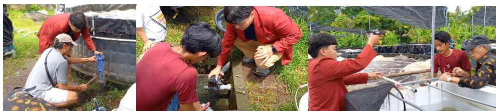
Gambar 6. (a) Pelatihan Pemasangan Mekanik; (b) Pelatihan Pemasangan dan Cek Kondisi Pompa Air Kolam; (c) Pelatihan Pemasangan Sensor pada Kolam Ikan Nila
