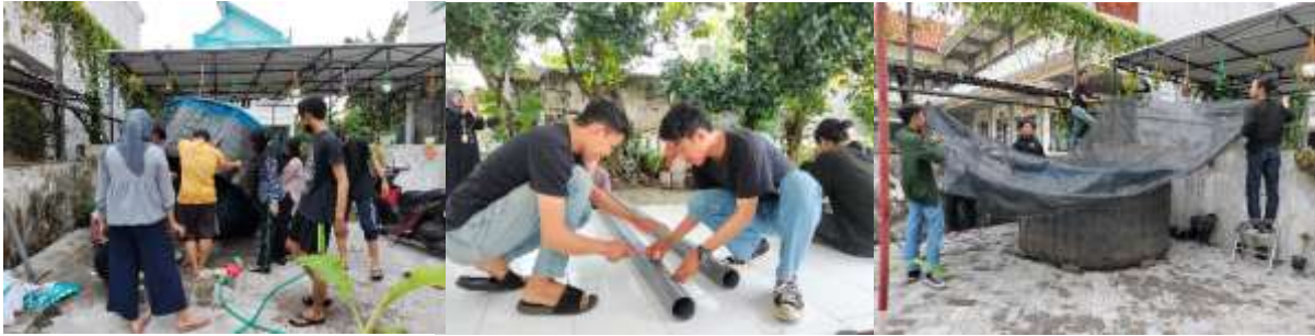
Gambar 1. Pemasangan kolam terpal bulat (a) Pemotongan Pipa Pembuangan (b) Pemasangan Paranet (c)
