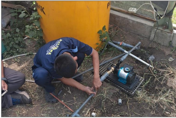
Perakitan pipa di sekitar tandon dan pompa
