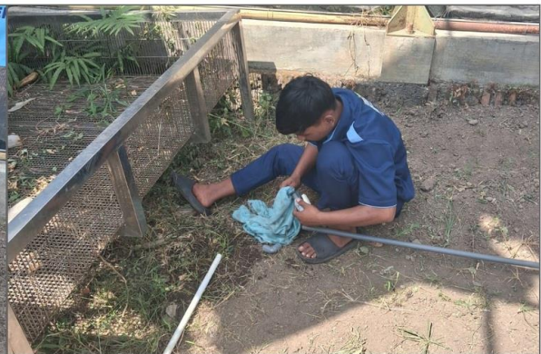
Persiapan dan pembersihan sambungan pipa
