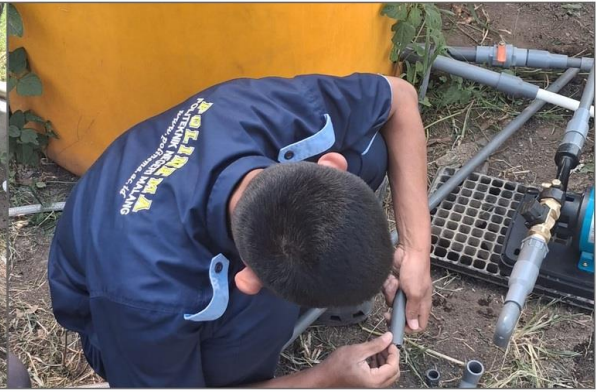
Penyambungan jaringan pipa PVC
