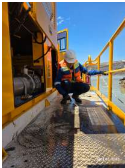
Gambar 4. Praktik pembersihan unit menggunakan pompa air secara benar dan aman untuk mengurangi risiko korsleting dan tersetrum.
