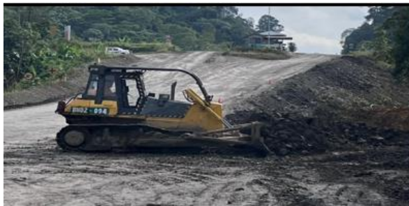
Gambar 13. Kegiatan Perbaikan Badan Jalan Menggunakan Bulldozer .
