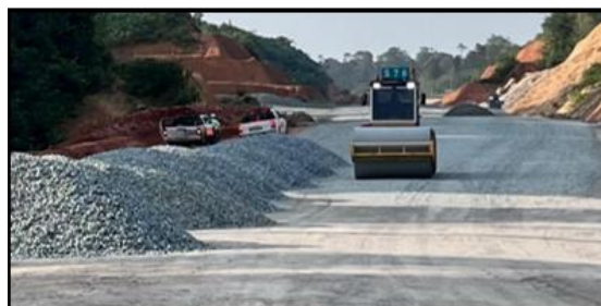
Gambar 12. Kegiatan Pemadatan Menggunakan Compactor .
