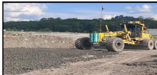
Gambar 9. Proses Pemeliharaan Jalan ( Grading ) Menggunakan Motor Grader .
