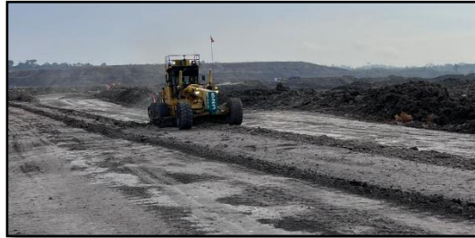
Gambar 11. Kegiatan Grading menggunakan Motor Grader .
