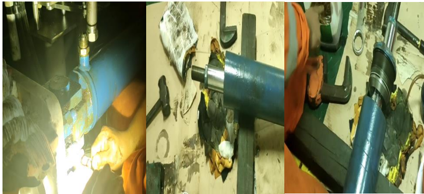
Gambar 2 Pemasangan Mechanical Seal Pada Hidraulik Steering Gear .
