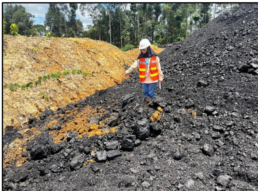
Gambar 4 Kondisi Tanggul Stockpile Baru.
