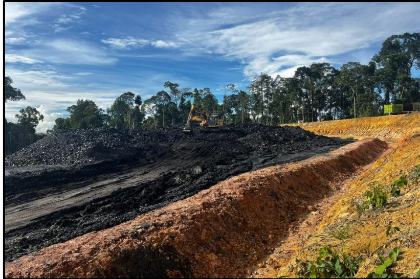
Gambar 3 Kondisi Tanggul Stockpile Lama.
