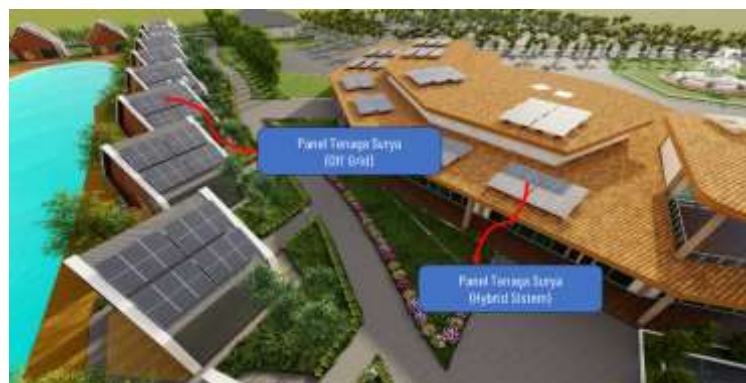
Gambar 13. Sistem Panel Surya.
