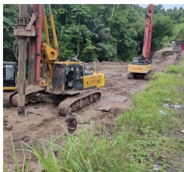
Gambar 3. Penambahan Alat Pengeboran Bore Pile.
