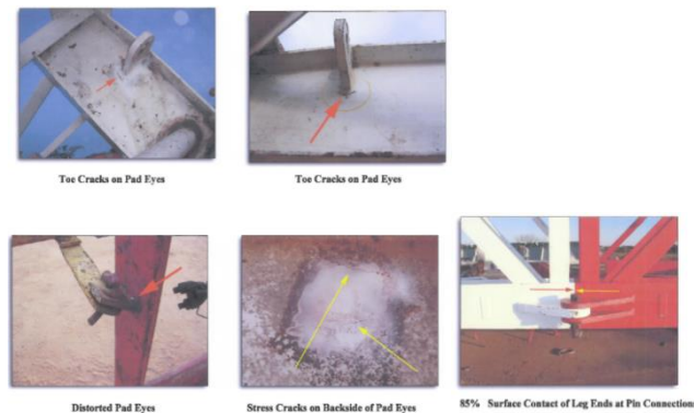
Gambar 8. Inspeksi Visual Pada Pad Eye Dan Sambungan Pin Inspeksi raising line, Guy-line dan Wire rope
