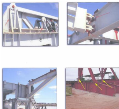
Gambar 11. Area Kritis Substruktur Rig Yang Menjadi Fokus Inspeksi. Dokumen dan Catatan Persyaratan
