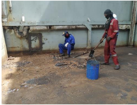
Gambar 1 Pengetokan main deck Sumber: olah pribadi
