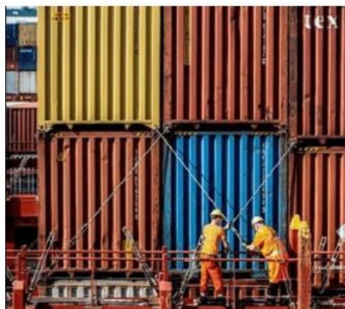
Gambar 2. Pengikatan/lashing single lashing pada peti kemas
