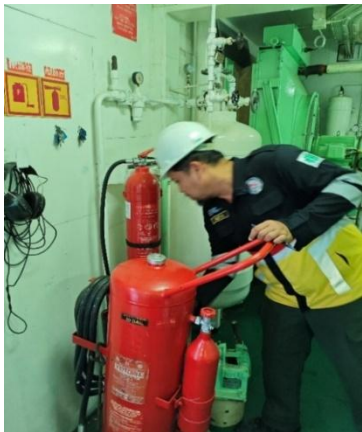
Gambar 4. Dokumentasi Saat Perawatan APAR Sumber: Dokumen Pribadi (2024)
