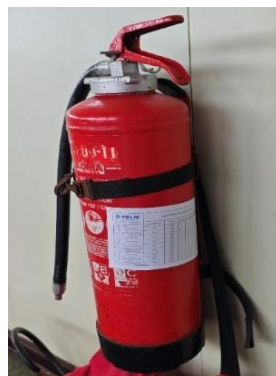
Gambar 1. Nozzel APAR CO^2 tidak terpasang Sumber: Dokumen Pribadi 2024
