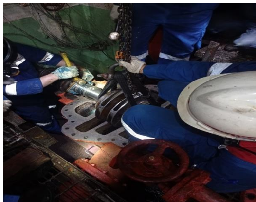
Gambar 8. pemasangan setelah proses overhaul .Sumber: Penulis (2024)
