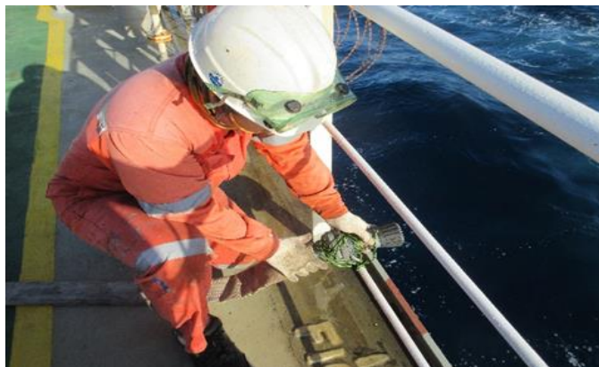
Gambar Pemasangan Razor Wire
