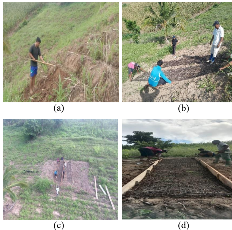
Gambar 2. Proses pemasangan jaring dimana, (a) Proses pembersihan lahan dari semak/tanaman liar, (b) adalah proses pembentangan jaring di atas lahan plot, (c) adalah proses pemasangan papan pembatas yang diambil dari atas menggunakan drone, dan (d) adalah bentuk plot yang sudah terpasang jaring dan papan pembatas.
