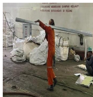
Gambar 49. Mengatur Lokasi Kerja – Beban Berat.
