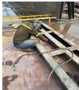
Gambar 30. Mengatur lokasi kerja –Nyamuk
